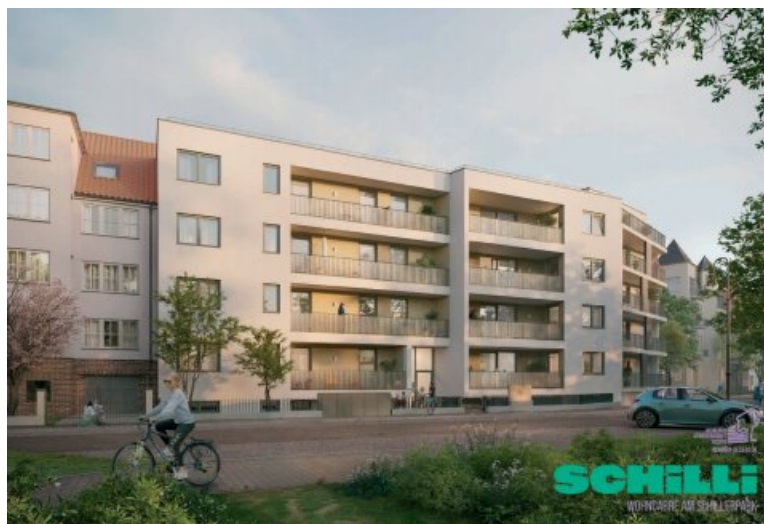
Neubau in der Ringstraße 36
