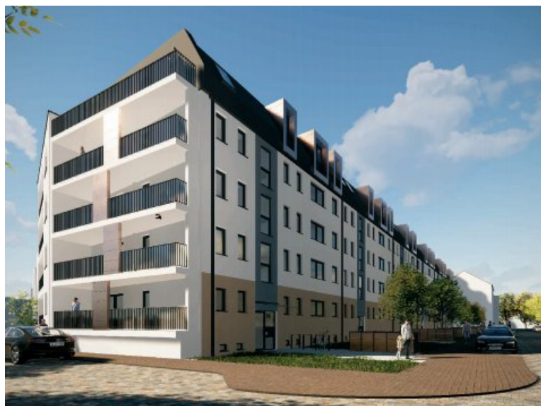
Modernisierung der Mozartstraße 4–14
