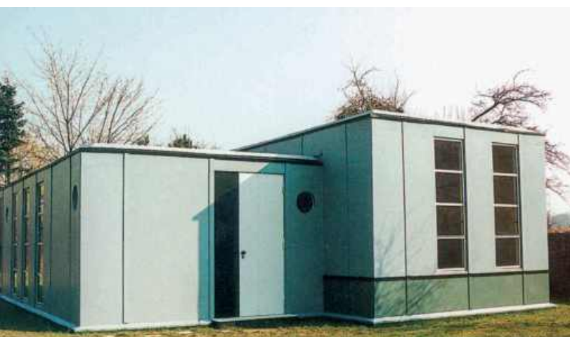
Stahlhaus in Dessau
